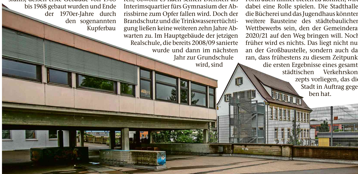
Der Stelzenbau der bisherigen Realschule (links) soll abgerissen werden. Der Schulhof wird schon in den kommenden Sommerferien für die Grundschüler gerichtet. Rechts das Haus Marquardtstraße 44, weiterer Baustein des Schulzentrums.
