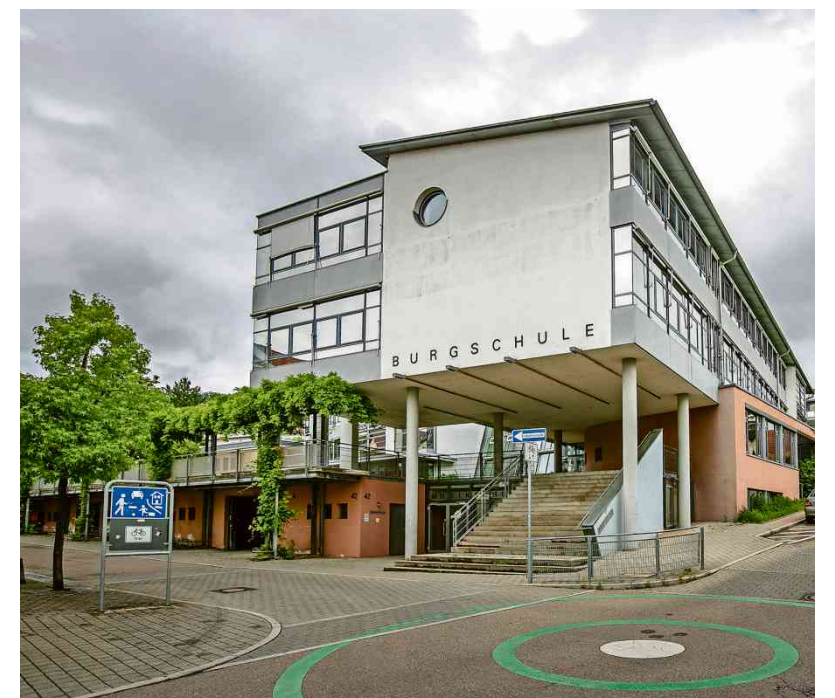
Die Burgschule wird im kommenden Jahr mit der Realschule das Gebäude tauschen. Auch sie wird in den kommenden Monaten saniert.
